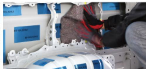
面積の大きい、ルーフ、サイドパネルに防音・防振・吸音材をセットした Phase I です。基本施工になります。
